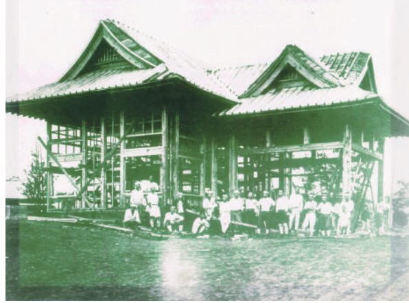
昭和4年のものと思われる建設中の写真。善光寺をモデルにしたと言われる入母屋造りと、格子状の窓を組み合わせた独特の和洋折衷形式のデザインが特徴的。宮大工の経験を持つ地元建設会社が手がけた。(写真:北軽井沢観光協会所蔵)
