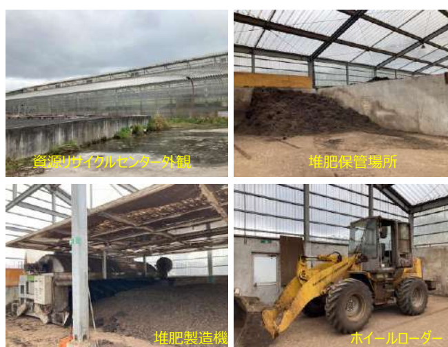
図 20 長野原町資源リサイクルセンター
