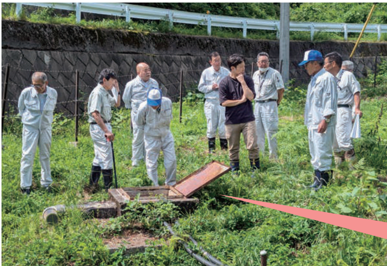
▲中部簡易水道中央第一水源
