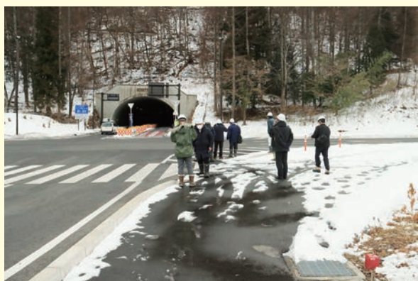
▲大柏木川原湯トンネル付近
