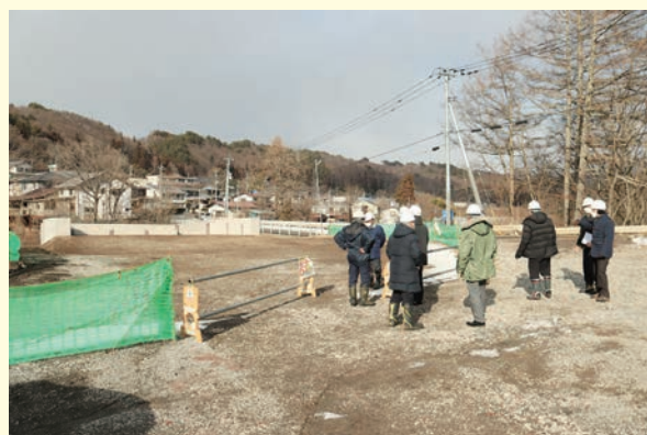
▲国道146号(古森工区)
