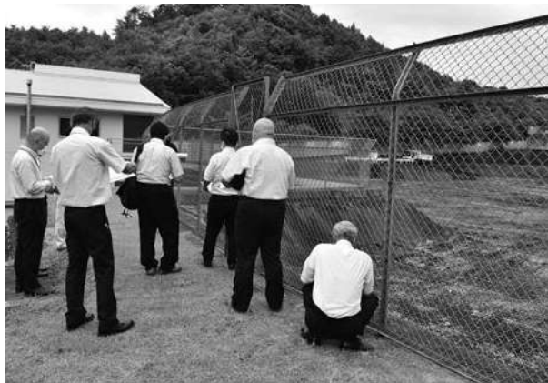
▲一般廃棄物最終処分場にて令和5年4月頃から他組合の焼却灰の受け入れが始まることなど説明を受けました。受け入れにあたり、高度処理施設の建設や上水道の引き込み工事を予定しています。
