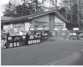
北軽井沢区内ごみ集積施設建築工事 (事業費：1,848万円)
