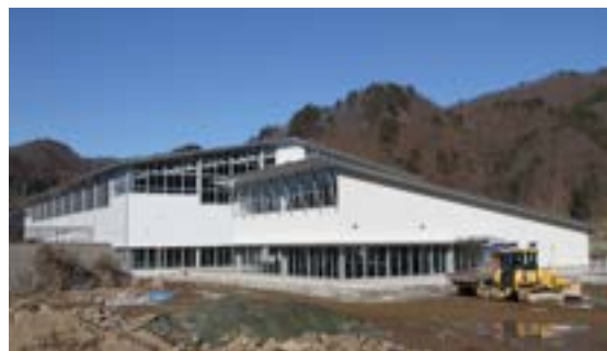
横壁地区に建設中の屋内運動場
