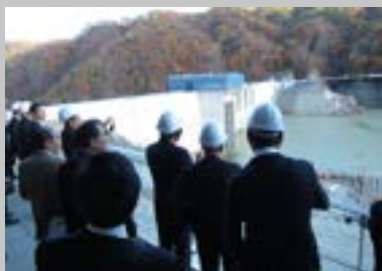
管理棟よりダムサイトの眺め
