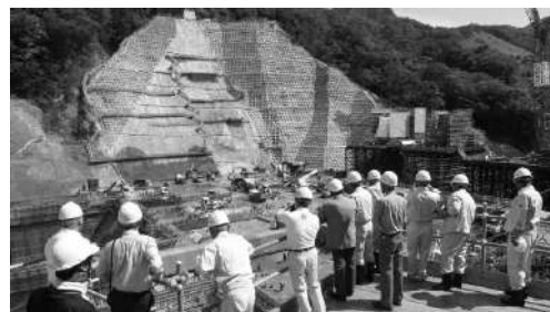
▲ 本体工事現場の現地視察
