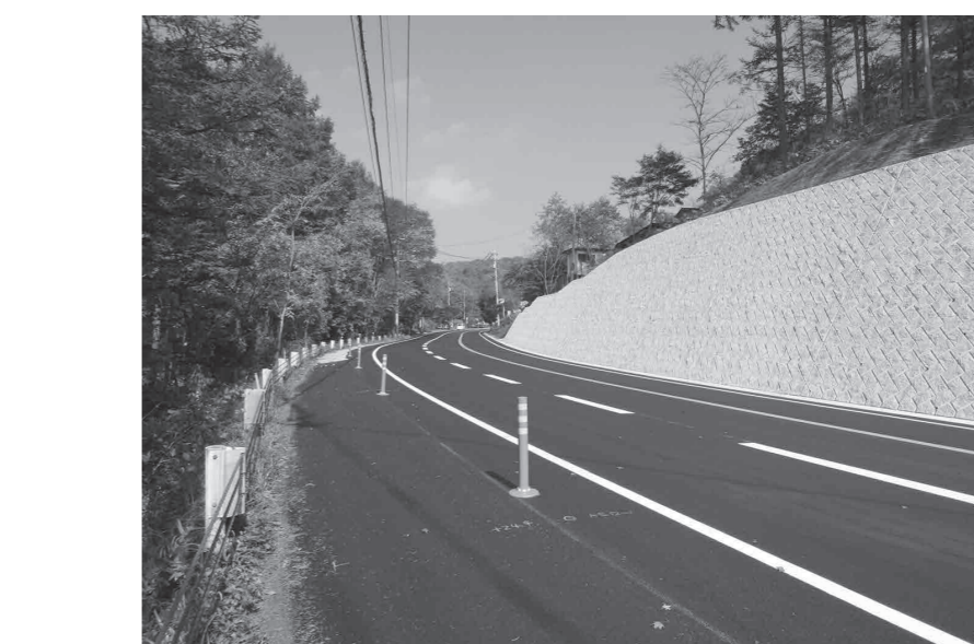
2車線になった国道292号
